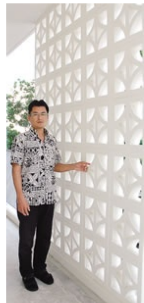
「風を通し緩やかに目隠しする花ブロックは、バルコニーをより使いやすくします」と伊良波氏=那覇市真地の集合住宅
